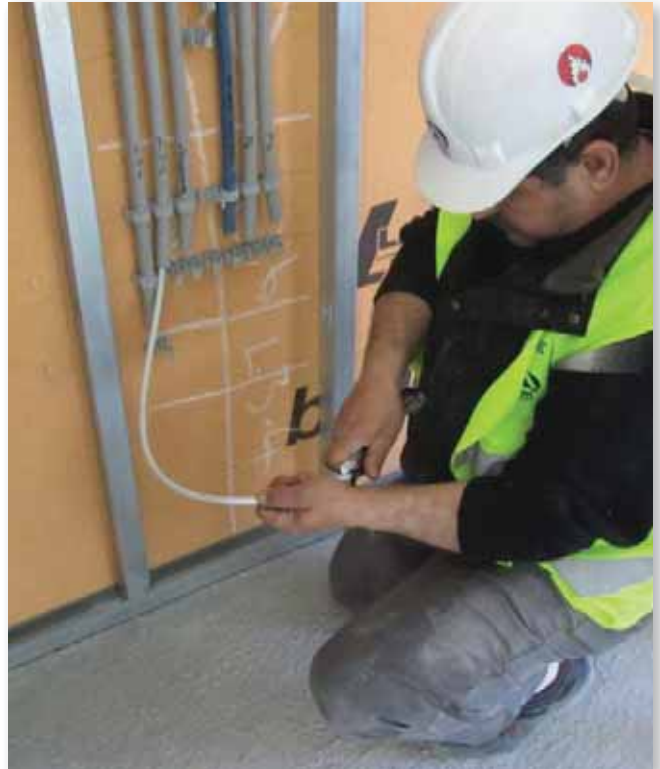
Kablo montajında kılıfın kolay sıyırılması, zaman kazandırır.
